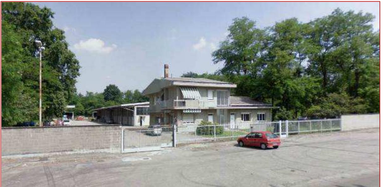
La costruzione ad uso ufficio si presenta con struttura portante in cemento armato gettato in opera e murature perimetrali di tamponamento, serramenti a battente in legno e vetro ed elementi oscuranti avvolgibili in pvc. Copertura a doppia falda con elementi di rivestimento.
